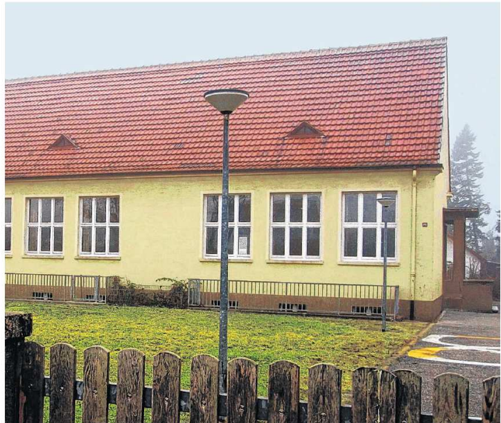
Ein Gebäude und damit ein Bild, das es nicht mehr lange geben wird: das alte Schulgebäude in der Lüderitzstraße in Rheinau-Süd wird abgerissen, das Grundstück verkauft und bebaut. Der Verkaufserlös finanziert die Sanierung des Rathauses. BILD: TIN
